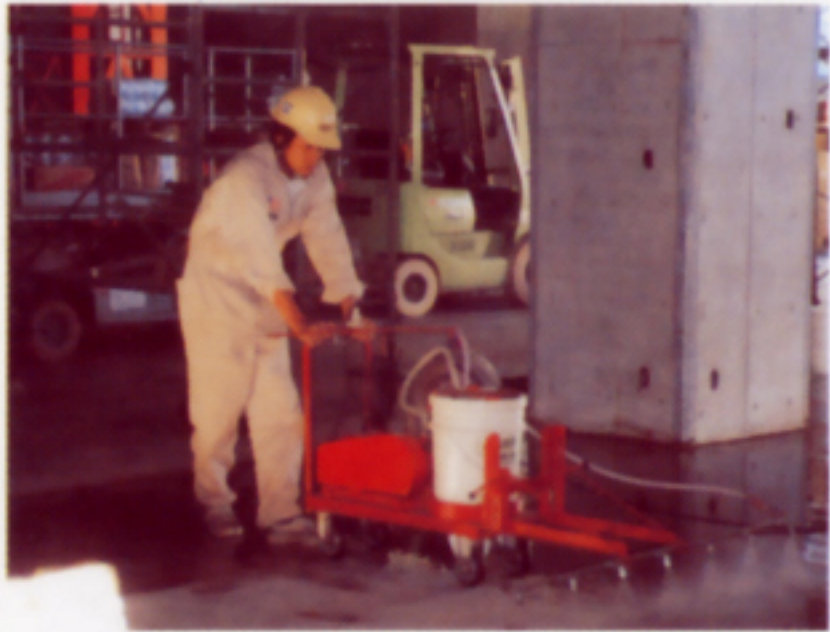
2 A/F施工作業
